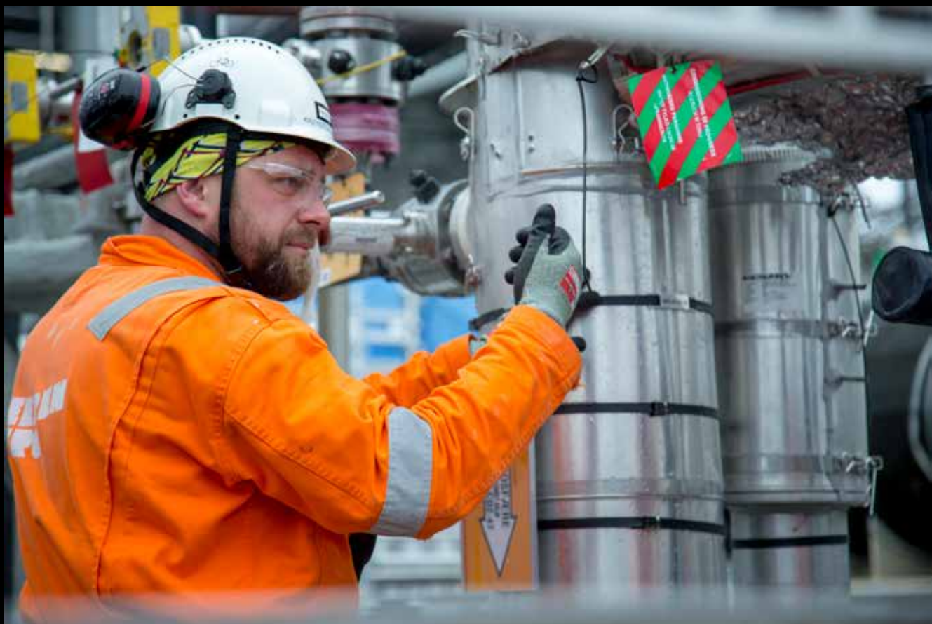
Isolasjonstekniker Krzysztof Mierzwinsky jobber for Beerenberg med isolasjon på den nye mottaksmodulen for Polarled og Aasta Hansteen ved Nyhamna.
