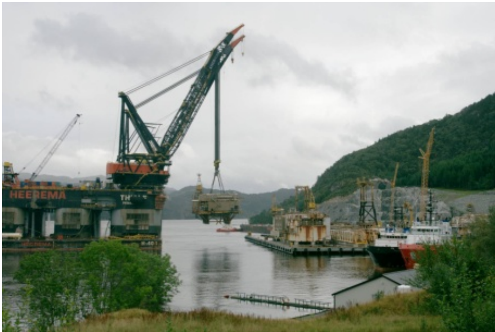
Figur 2 Tungløft av moduler med kranfartøy inn til anlegget i Vats
