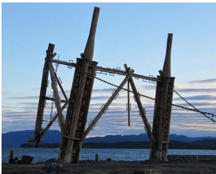
Figur 8 Velting av stålunderstell på Aker Stord
